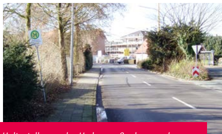
Haltestelle vor der Umbaumaßnahme und ...
